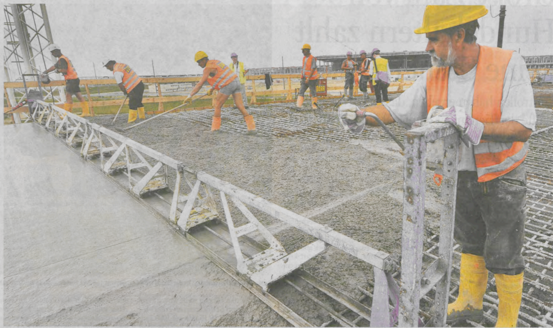
Es ist vollbracht: Bauarbeiter betonieren die letzte Brücke zur Straßenanbindung des künftigen Hauptstadtflughafens BBI
